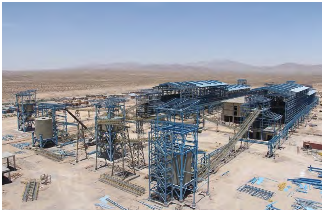
ساختمان‌های پروژه گلفا (گل گهر سیرجان)
