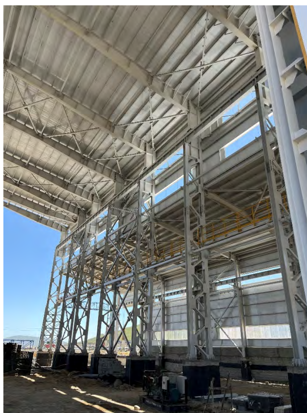
ساختمان کوره آند و DSB , BCC پروژه کاتد مس سونگون
