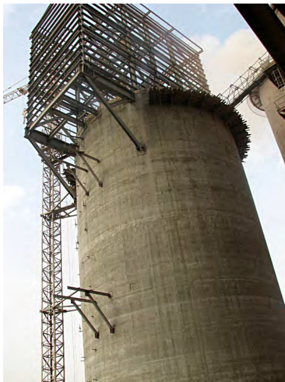
سازه سيلوی هموژن ساز به ظرفيت ۱۲۵۰۰ تن به قطر ۱۶ متر و ارتفاع ۷۹ متر (کارخانه سیمان آبيک)
