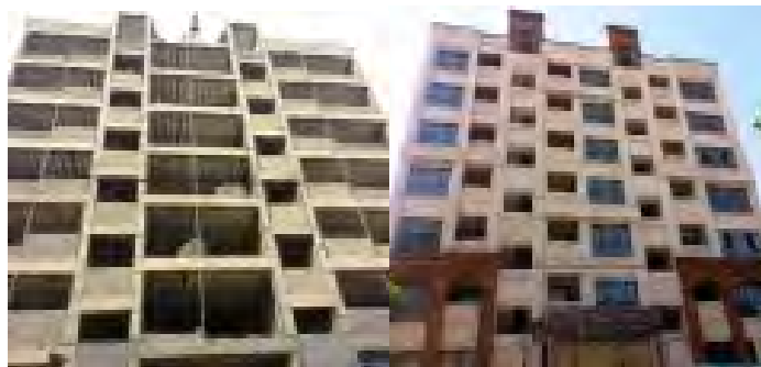
ساختمان مسکونی حسینی
