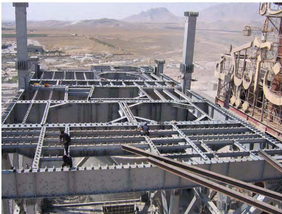
سازه ساختمان پیش گرمکن به ارتفاع ۱۴۰ متر (کارخانه سیمان آبیگ)
