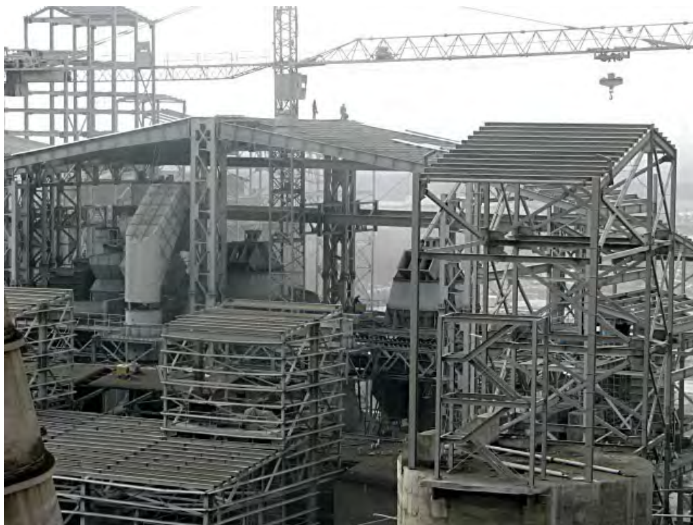
سازه ساختمان آسیاب سیمان (کارخانه آبیگ)
