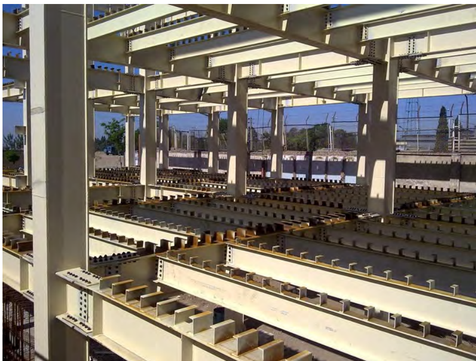
سازه ساختمان تحقیقات و توسعه (شرکت سایپا)
