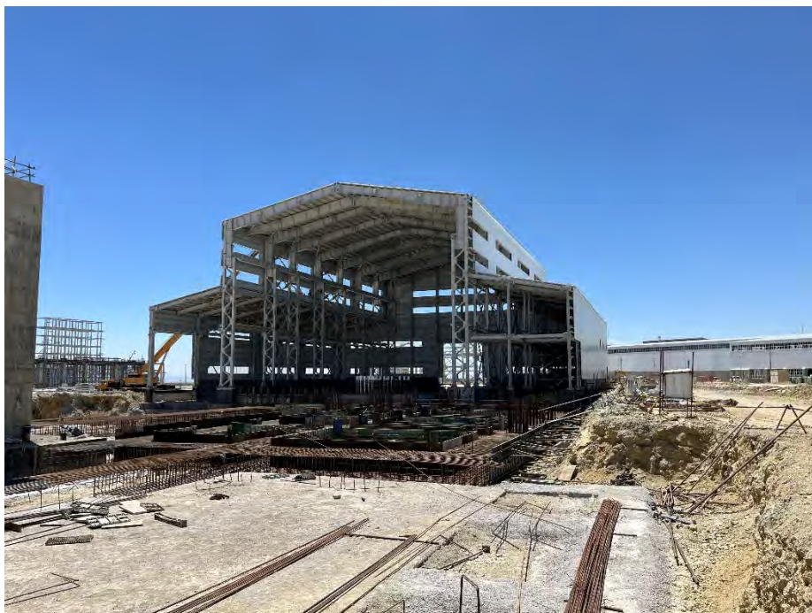
ساختمان کوره آند و DSB , BCC پروژه کاتد مس سونگون
